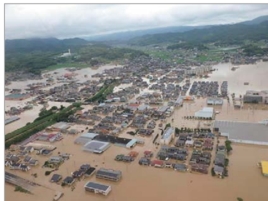
岡山県倉敷市真備町 (東京消防庁提供)
